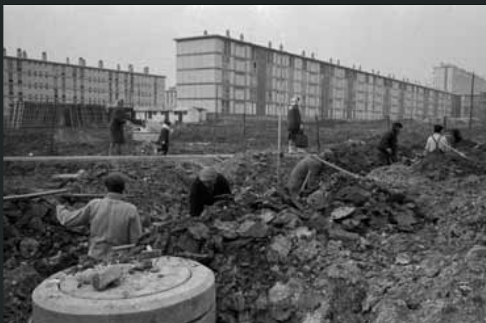
Mise en place de canalisations, 1961.
